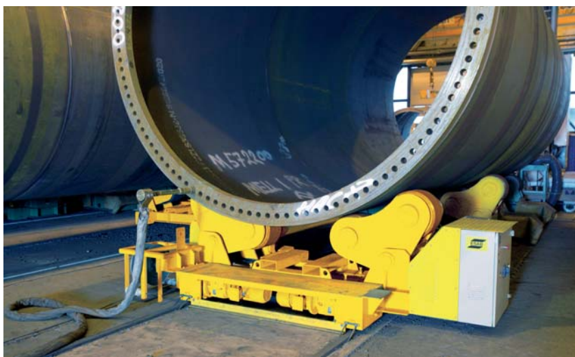
Montážní linka pro sestavování věže větrné elektrárny.
