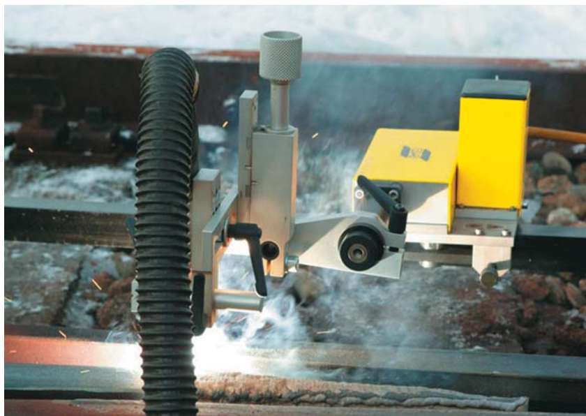
Obr. 2 ESAB Railtrac BW1000 vytvářející tvrdonávar na kolejové hlavě plněnou elektrodou OK Tubrodur 15.43.
