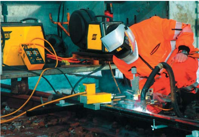
AristoMig 400 pomáhá na železnici
